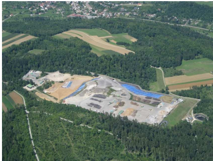
Luftbild der Entsorgungsanlage Walddorf im Landkreis Calw (Stand 2012)
